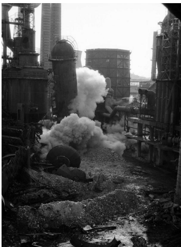
14-15. kép: II. sz. léghevítő robbantása. Ózd, 1994. / IV. léghevítő kémény robbantása. Ózd, 1996. 370
