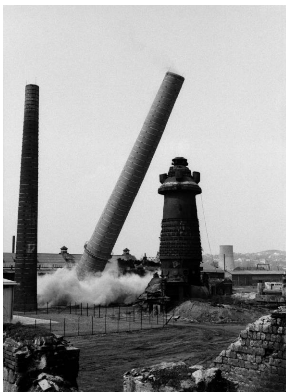
14-15. kép: II. sz. léghevítő robbantása. Ózd, 1994. / IV. léghevítő kémény robbantása. Ózd, 1996. 370
