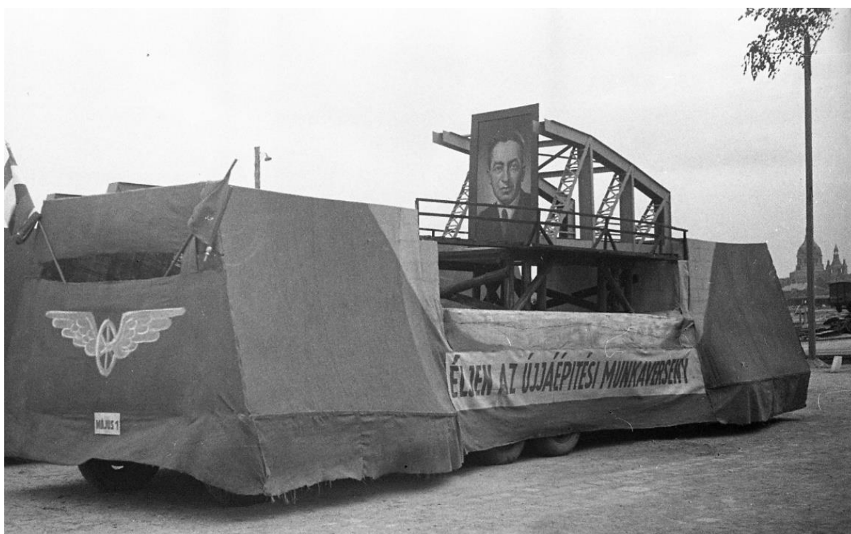
29. kép: MÁV hídépítők 1948. május 1-i felvonulási „kelléke” (MÁV Arch. X20229619)
