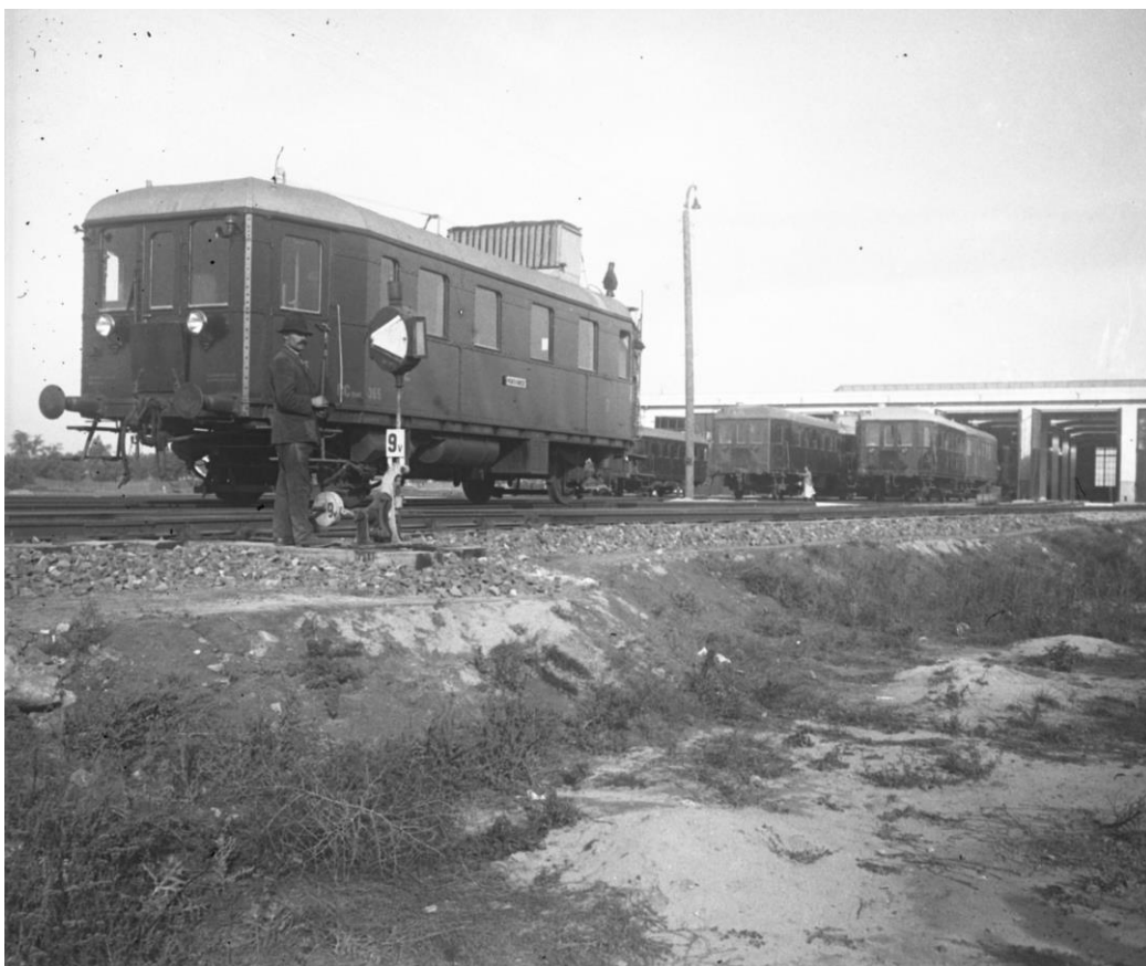
22. kép: BCmot motorkocsik (Frigyláda) a szentesi motorszín előtt, 1930-as évek (MÁV Arch. X20257771)
