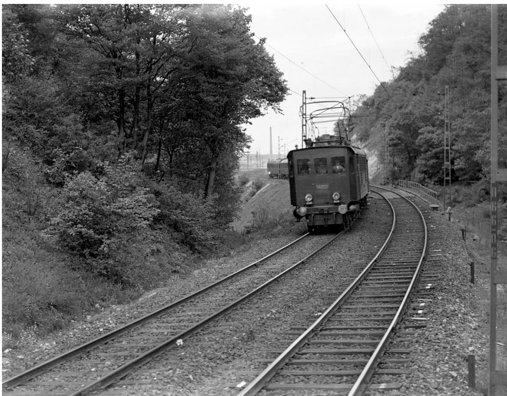
23. kép: Kandó rendszerű V40 sorozatú villamos mozdony személyvonatot húz Alsógalla (ma Tatabánya) környékén, 1932–1944. (MÁV Arch. X20258165)
