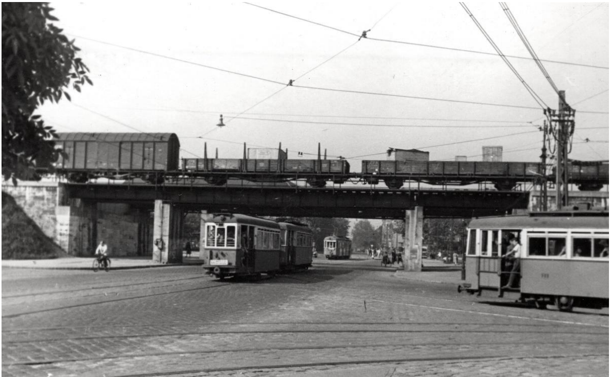
16. kép: Budapest–Cegléd vasútvonal zuglói szakaszának „felemelése”, Thököly úti halálsorompó kiváltására megépített vasúti felüljáró, 1948 (Fortepan No. 131927)
